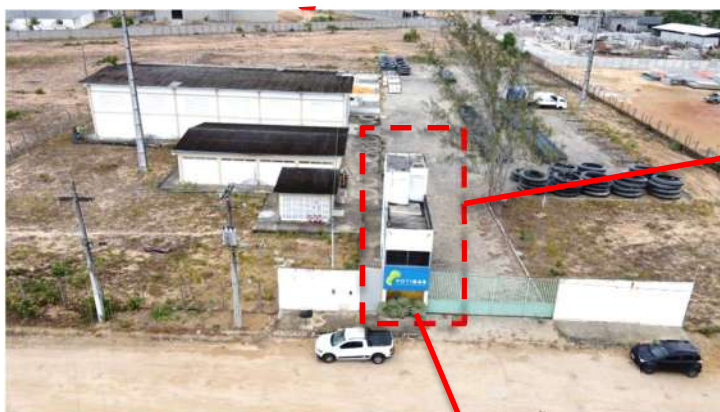
Foto 1 – Vista aérea da guarita.
