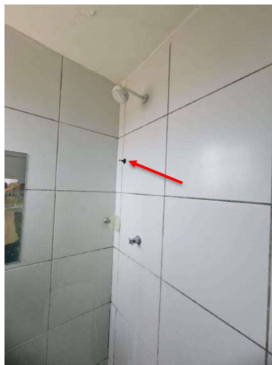
Foto 16 – Falta de acabamento no registro
