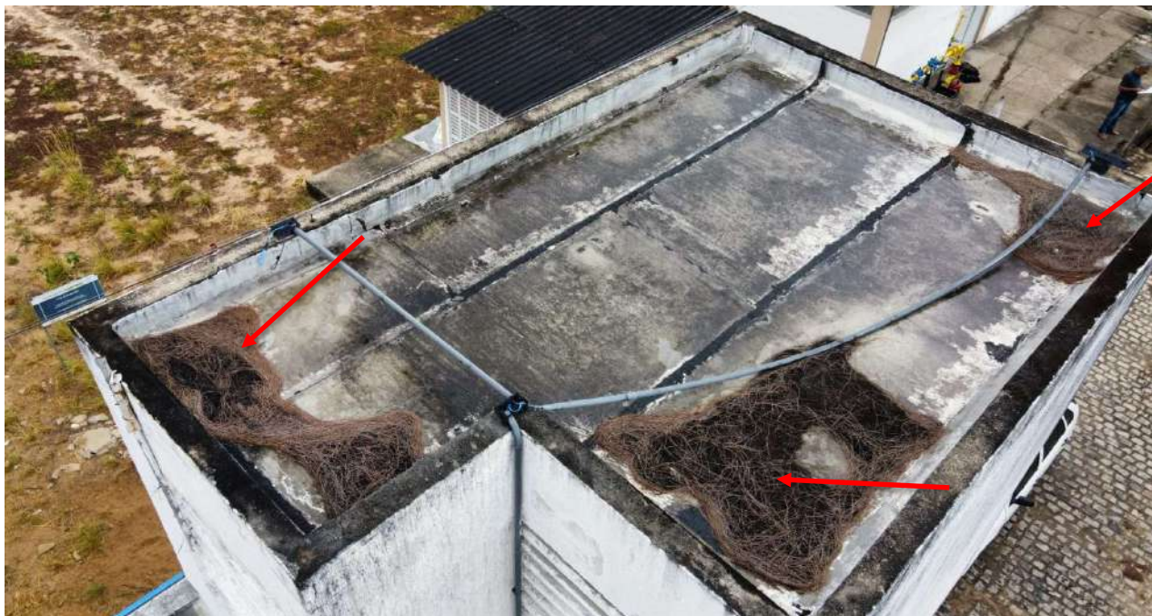
Foto 4 – Acúmulo de vegetação seca sobre a manta da cobertura. Probabilidade de entupimentos na tubulação pluvial. Ausência de manutenção periódica.
