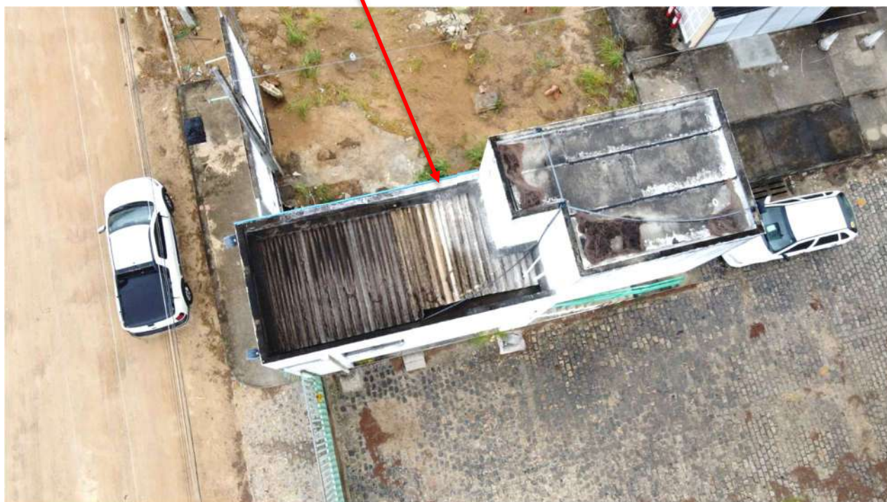
Foto 3 – Vista aérea da cobertura da guarita.
