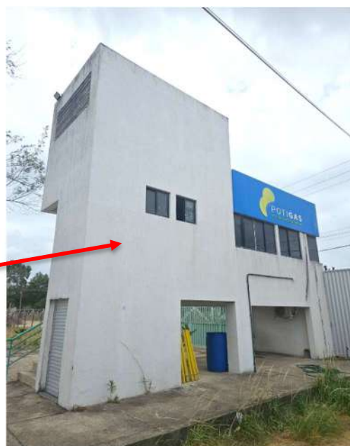
Foto 2 - Fachada lateral da guarita.
