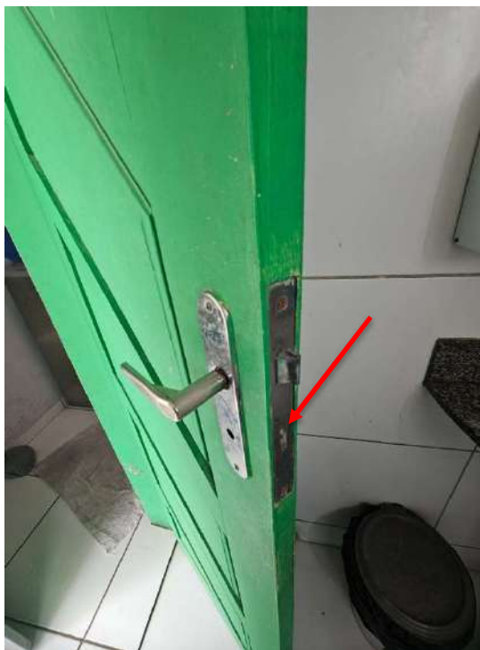
Foto 15 – Fechadura danificada
